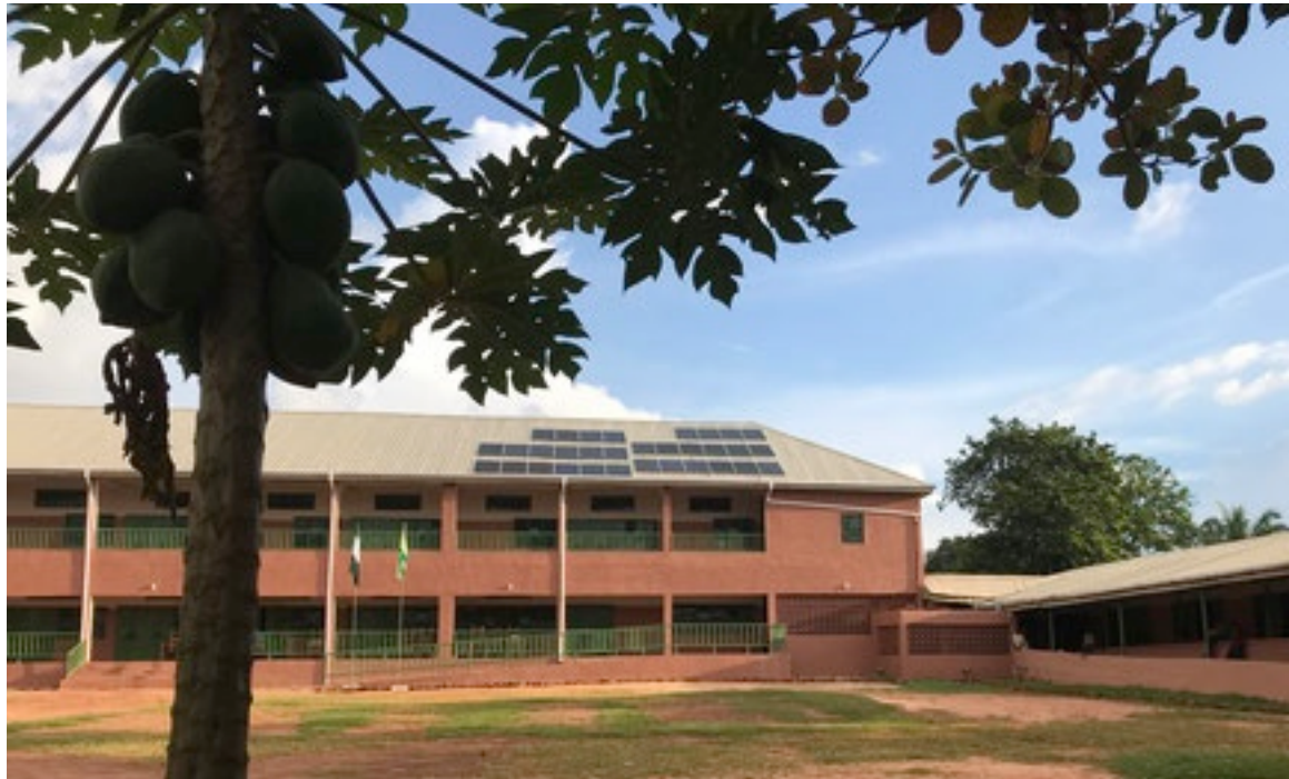
Abb 17: Solarstromanlage mit 16 kWp auf Schulhaus in Amokwe / Nigeria
