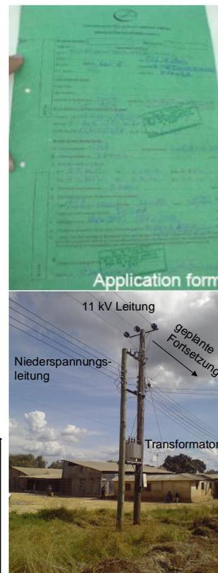
Abbildung 5-1: nächste Transformerstation (eigene Foto)
